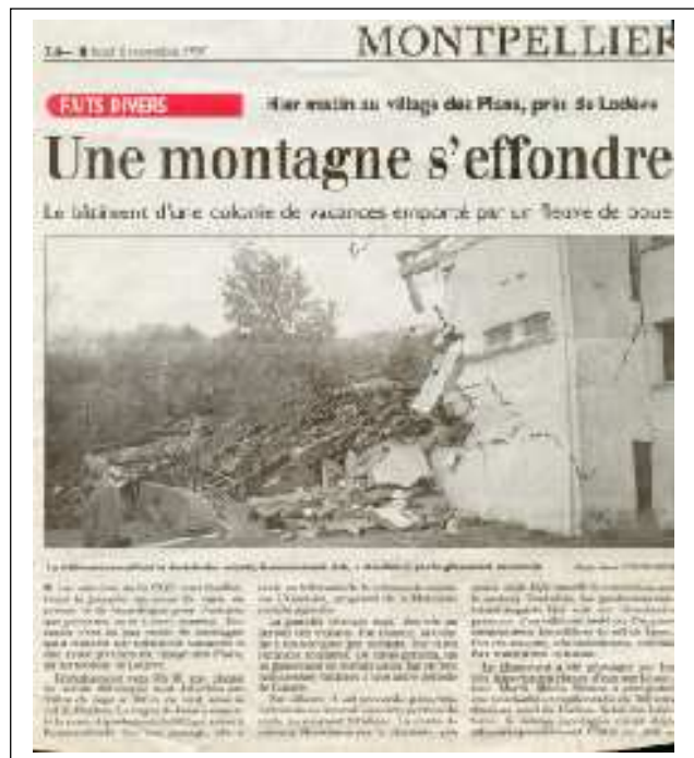
Figure 32 : Coulée de boue du Col du Perthus (commune des Plans): extrait de presse montrant l'ampleur de la destruction du bâtiment accueillant le dortoir des enfants, heureusement vide.
