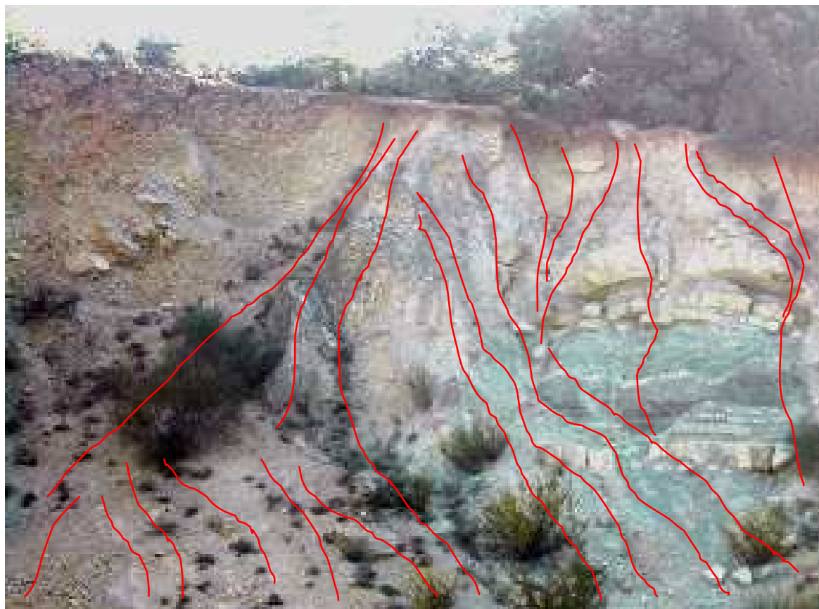
Figure 36 : Griffes de ravinement (superficiel) affectant un talus marneux (Trias)
