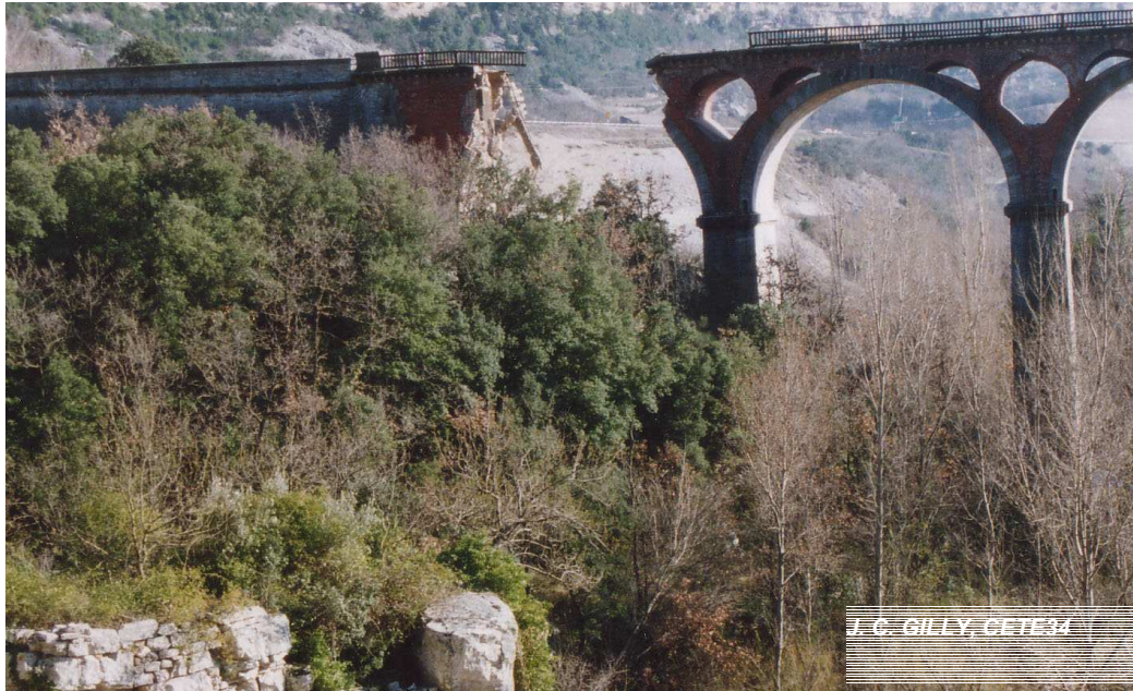
Figure 27 : Le viaduc de Pégairolles a été construit sur le bourrelet de pied d'un glissement de versant à mouvement lent, seulement visible au travers des dégâts que subissait régulièrement le viaduc (depuis 1860). Ouvrage ruiné et détruit en 1999.
