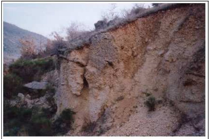
Figure 26 : Amorce de glissements en tête d'une ancienne carrière de grèze, le long de la RD151 (commune de Lauroux).
